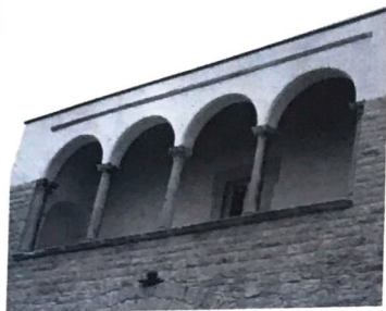
Particolare della loggetta al primo piano.
